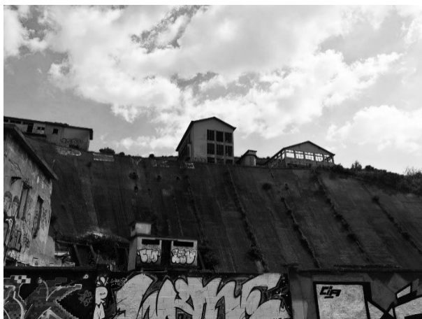
Figura 14 - Zona do Cubal, concha betonada
