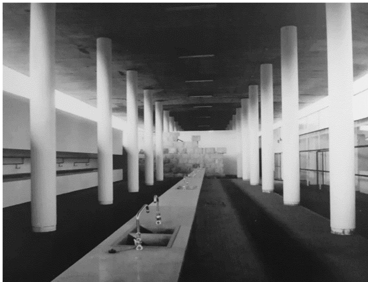
Figura 39 - Mercado de Braga - Bancada central de lavatórios ladeada por duas fileiras de pilares
